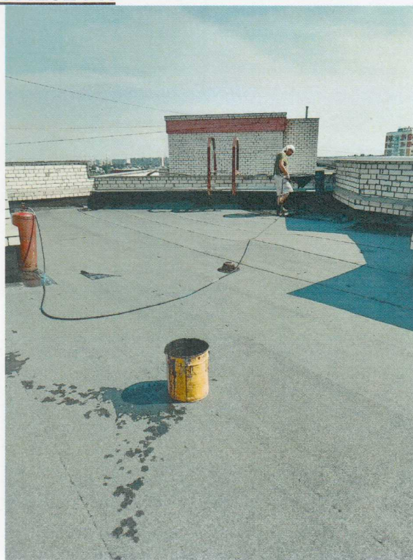
Устройство верхнего слоя. Подъезд №6-6А
