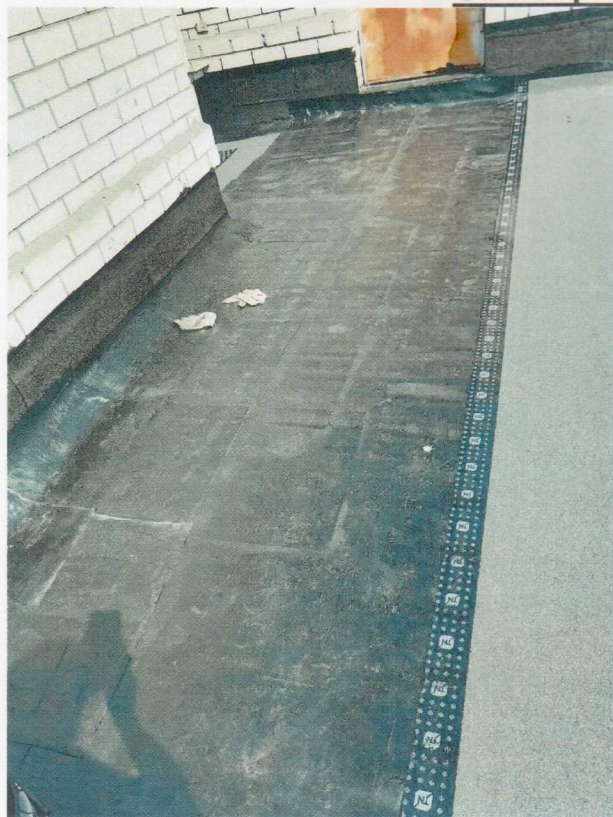
Устройство верхнего слоя. Подъезд №6-6А
