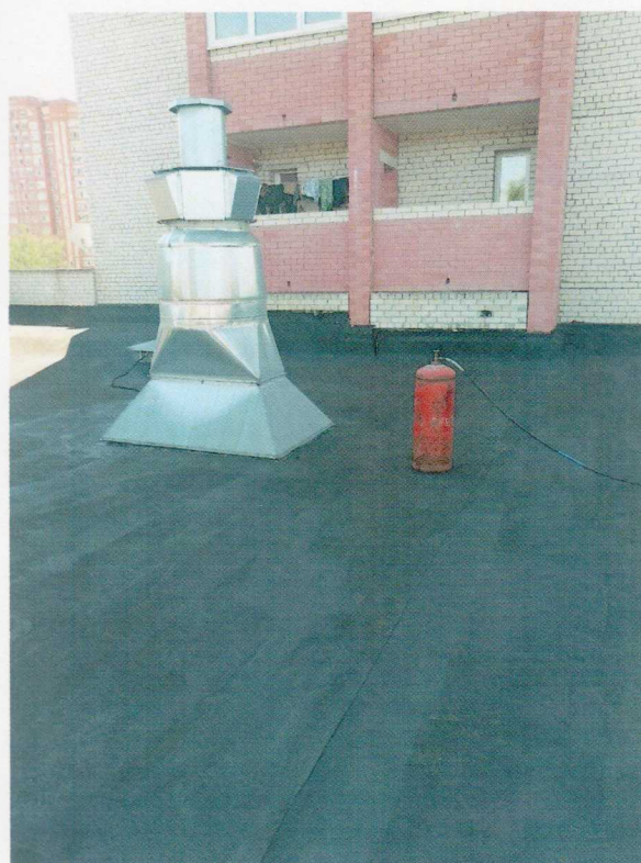
Нанесение битумного праймера по существующей кровле
