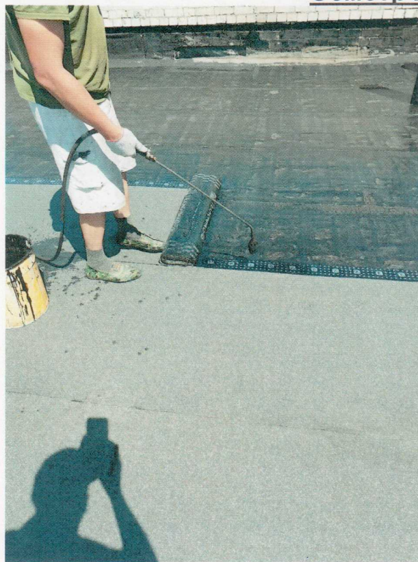
Устройство верхнего слоя. Подъезд №6-6А
