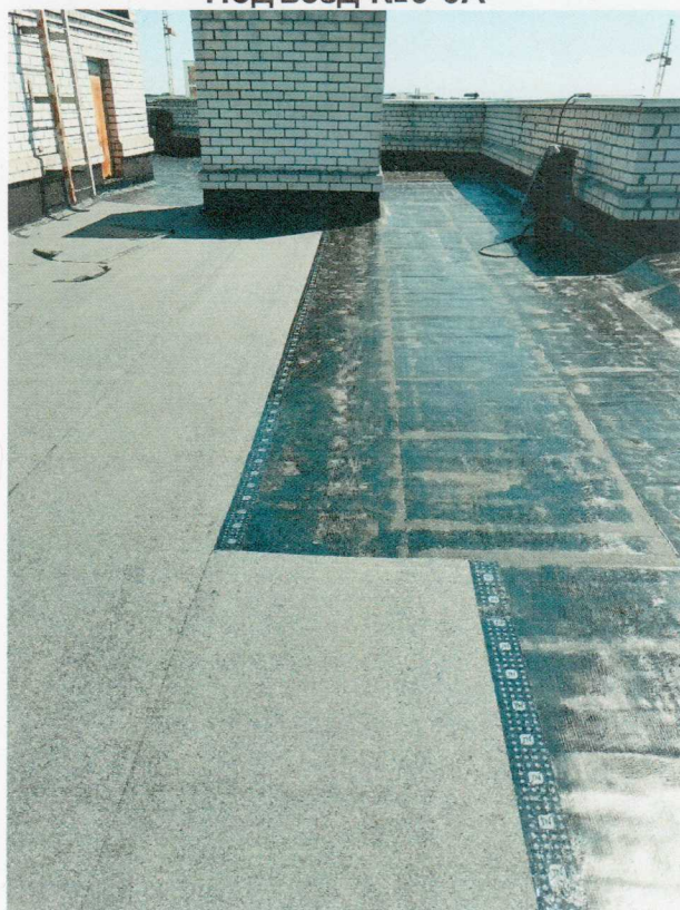
Устройство верхнего слоя. Подъезд №6-6А
